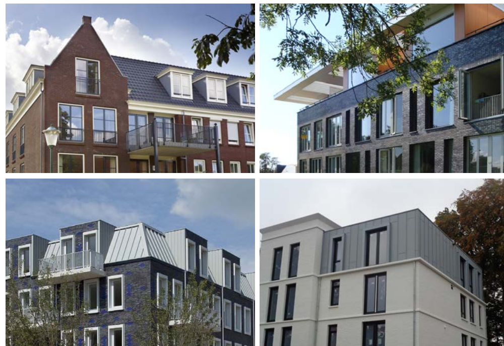
inspiratiebeelden: dak als afronding van het gebouw
