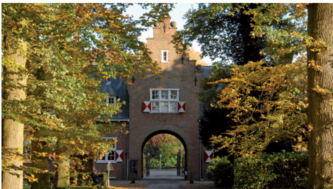
Poortgebouw Huis Doorn
